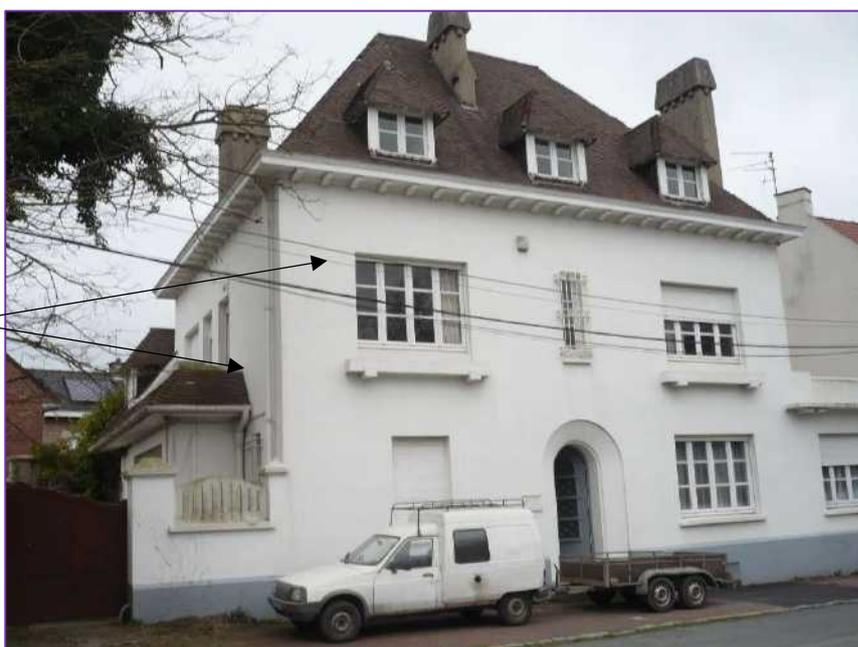
Façades recouvertes d'un enduit en ciment peint
