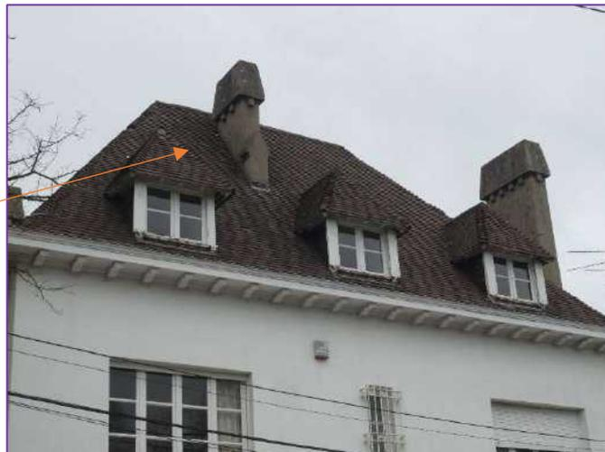
Toiture à plusieurs plans en ardoises reposant sur une charpente en bois et métallique
